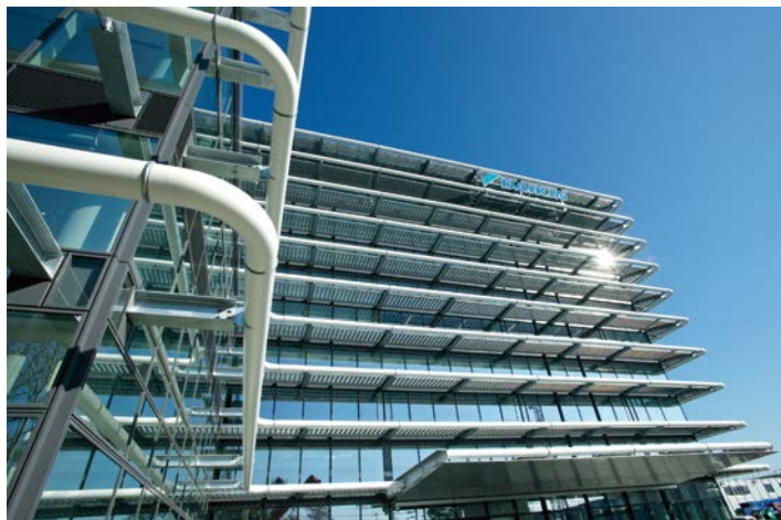
未来船プロジェクトで活用する、ダイキングループのテクノロジー&イノベーションセンター(TIC)
