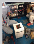
冷媒ガス充填
