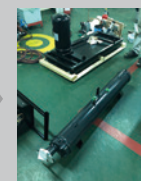
凝縮器 - 圧縮機取り外し
