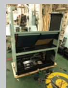
電装 BOX 取外し
