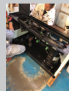
圧縮機 - フレーム取付
