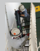
分解した部材を船内通路を通じて搬入
